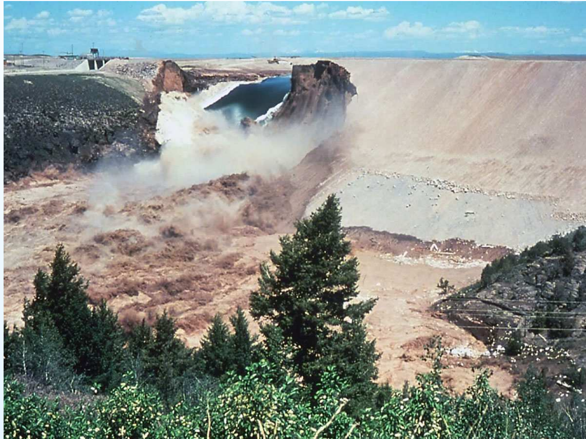
Teton dambreak (Idaho, 1976)
